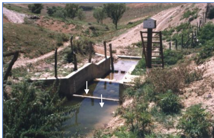
شکل ۹- اختلاف ارتفاع ۵۰ سانتی‌متری بستر آبراهه قبل از فلوم و کف فلوم (نمای قبل از فلوم حوضه نمونه)
