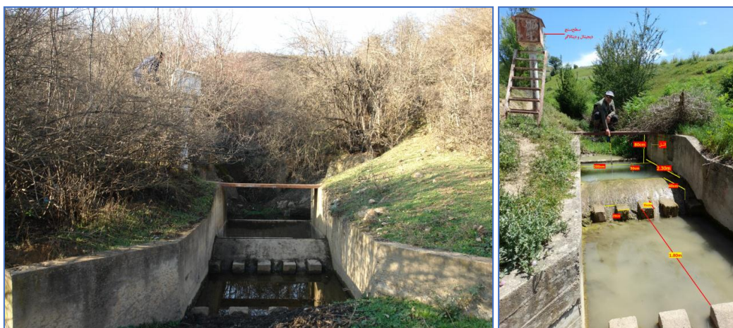
شکل ۷- فلوم‌های احداث‌شده در خروجی حوضه‌های نمونه (راست) و شاهد (چپ) و ابعاد آن
