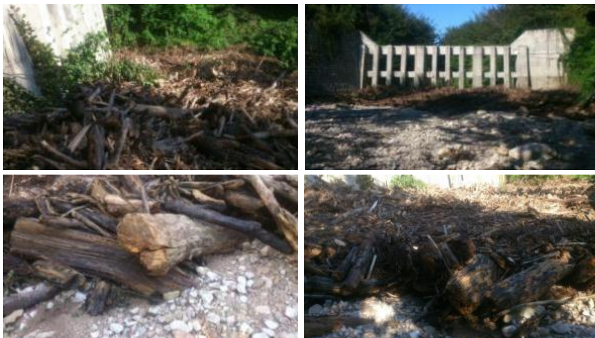
شکل ۵- اندازه چوب و رسوبات تله‌اندازی شده در پشت بند بزپل در واقعه سیل آبان ۱۳۹۸
